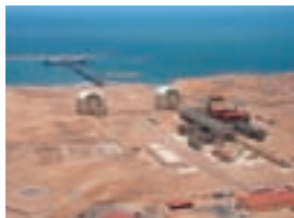
View of Peru LNG Project plant
